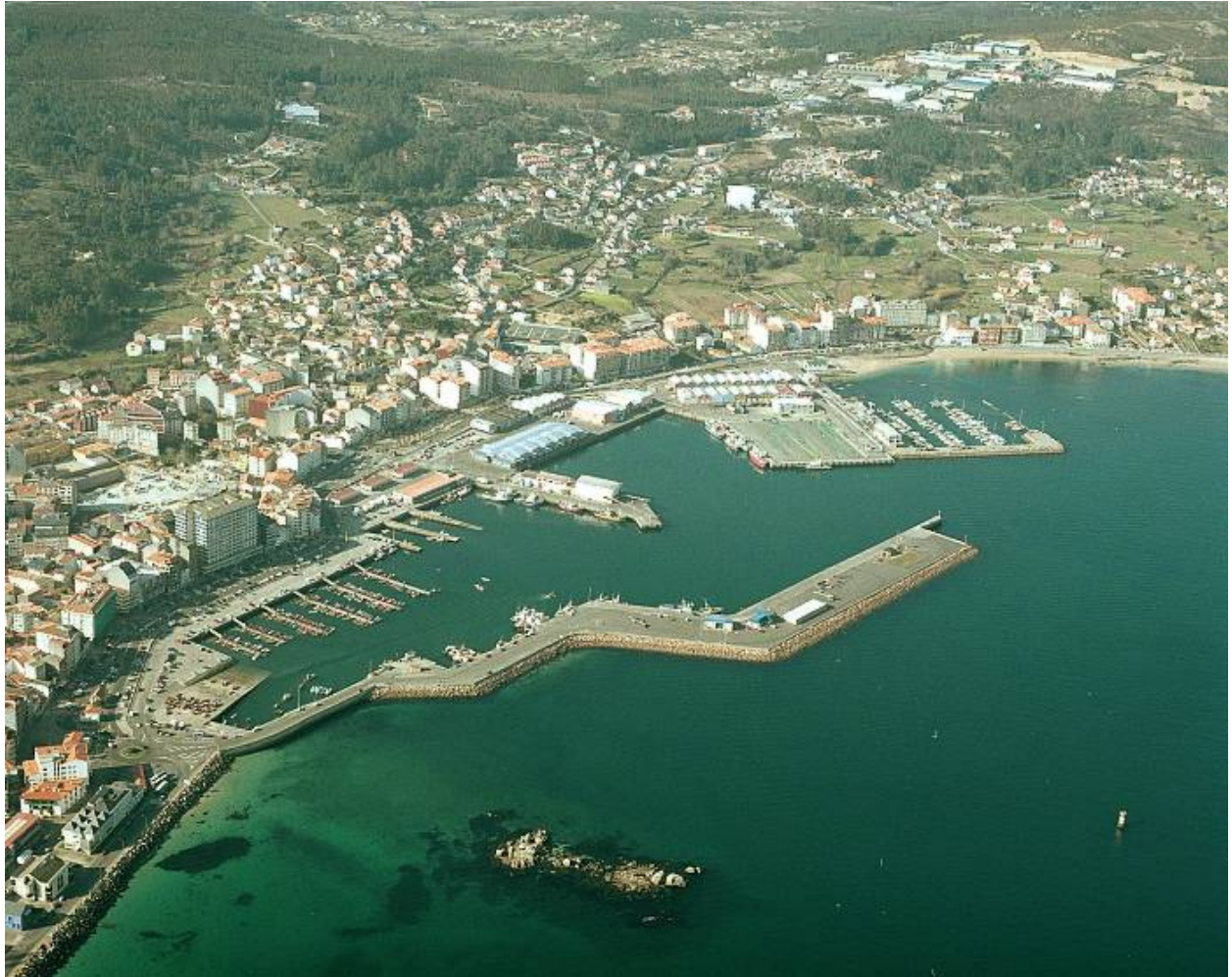
Imagen del puerto de Ribeira y de su entorno.
