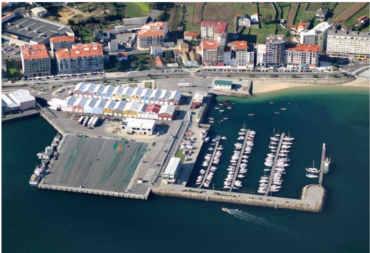
Foto 5. Dársena norte del puerto de Ribeira.
