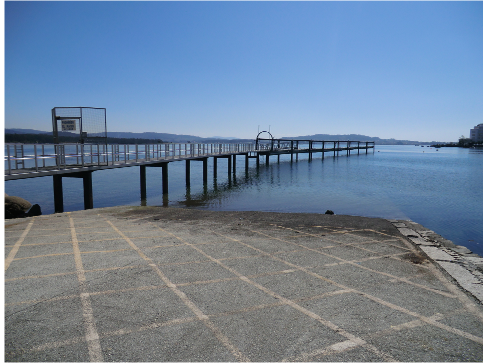
FOTO 33: PANTALANES FIJO Y MÓVIL Y RAMPA DE VARADA
